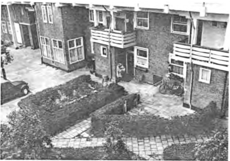
Dreigeschossige Reihenhäuser in Holland bilden einen Wohnhof mit vielfältiger Ausstattung. Breite, dem Haus vorgelagerte Übergangszonen mit Minigärten lassen das parkende Auto nicht als störend erscheinen. (Quelle: Günter)
